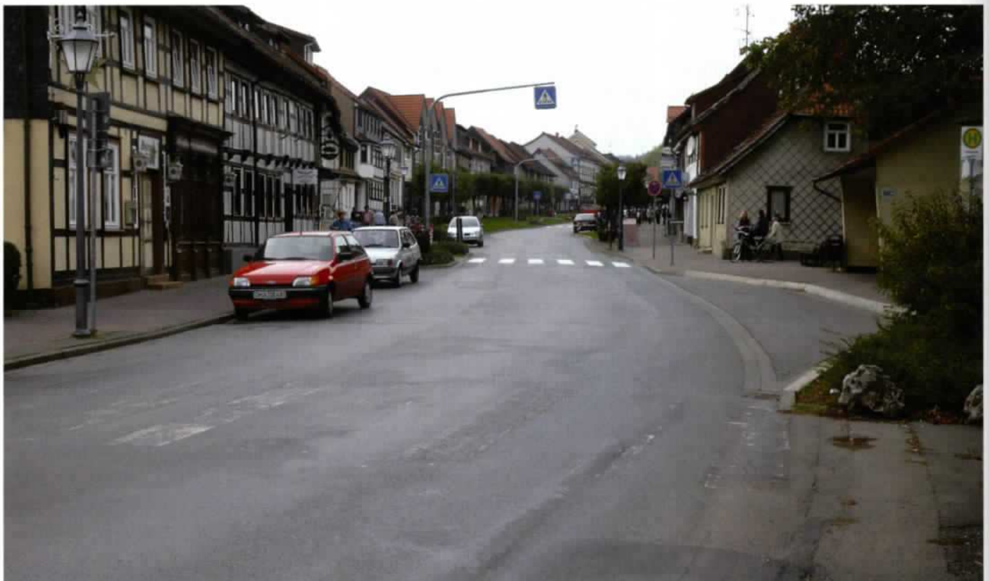
Das Foto zeigt einen Fußgängerüberweg, der um ca. 50 m weiter nach hinten verlegt wurde. Das alte Zeichen 293 (Fußgängerüberweg) wurde aber nicht ordnungsgemäß demarkiert. Für Kraftfahrer ist es am Tag kaum noch und nachts überhaupt nicht erkennbar.
