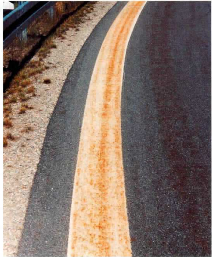
Rostablagerungen auf der Markierung und der Straße – wie auf den beiden Fotos zu sehen – sind eindeutige Hinweise auf einen starken Schneepflugeinsatz. Die in der Markierung eingebetteten Reflexperlen werden oftmals durch die Schürfleiste des Schneepfluges zerstört oder beschädigt. Für solche Schäden kann der Auftragnehmer nicht verantwortlich gemacht werden.
