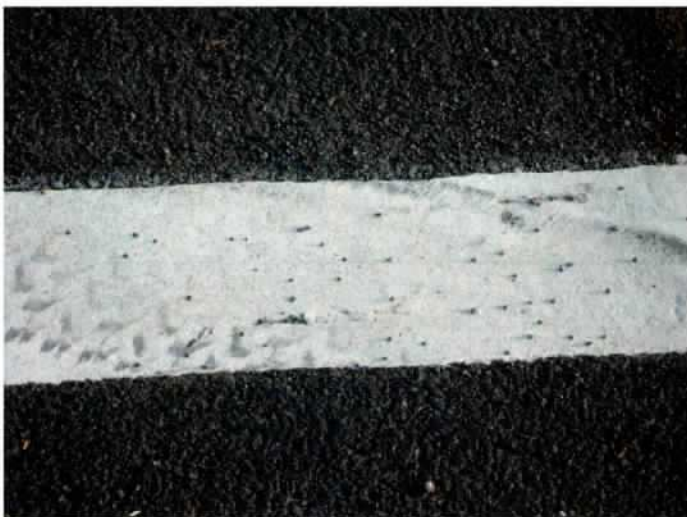
Die Fotos zeigen eine neue Dickschichtmarkierung einige Tage nach der Applikation auf einer neuen Fahrbahndecke. Hier wäre es sinnvoll gewesen zunächst eine Verkehrsfreigabemarkierung aus dünnschichtiger Farbe als „Opfermarkierung“ aufzubringen.
