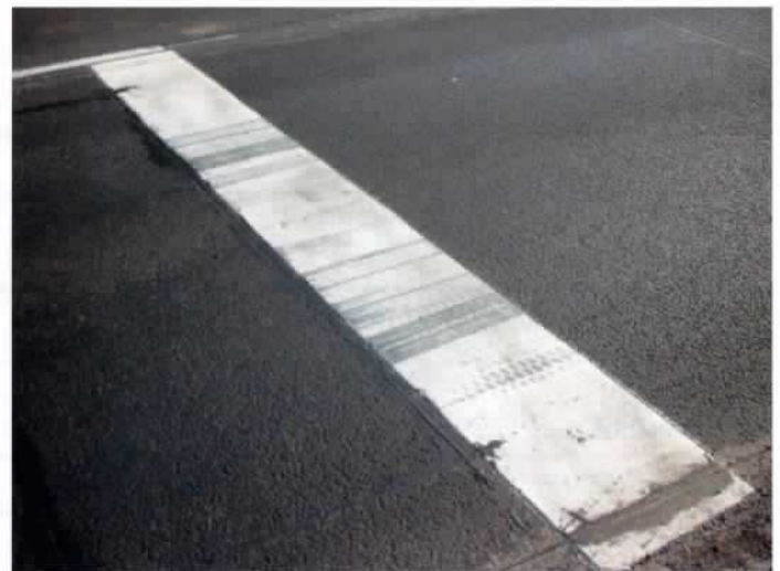
Die Fotos zeigen eine neue Dickschichtmarkierung einige Tage nach der Applikation auf einer neuen Fahrbahndecke. Hier wäre es sinnvoll gewesen zunächst eine Verkehrsfreigabemarkierung aus dünnschichtiger Farbe als „Opfermarkierung“ aufzubringen.
