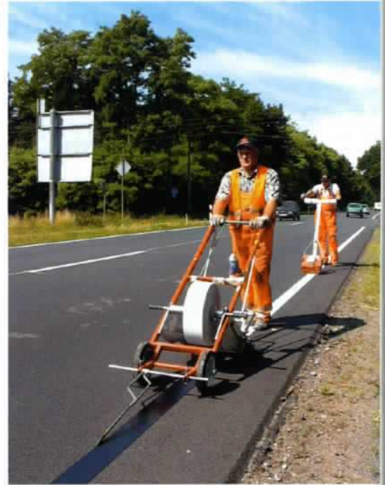
Das Foto zeigt die Applikation einer Markierungsfolie.
