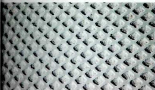
Die beiden Fotos zeigen Beispiele von strukturierten Typ II Markierungen. Die Nachtsichtbarkeit bei Nässe wird bei beiden Systemen durch die Erhebungen im Markierungsstoff selbst erreicht. Durch die ausgeprägten Strukturen wird auch hier der ungehinderte Abfluss des Regenwassers gewährleistet.
