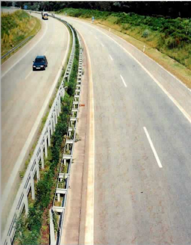
Rostablagerungen auf der Markierung und der Straße – wie auf den beiden Fotos zu sehen – sind eindeutige Hinweise auf einen starken Schneepflugeinsatz. Die in der Markierung eingebetteten Reflexperlen werden oftmals durch die Schürfleiste des Schneepfluges zerstört oder beschädigt. Für solche Schäden kann der Auftragnehmer nicht verantwortlich gemacht werden.
