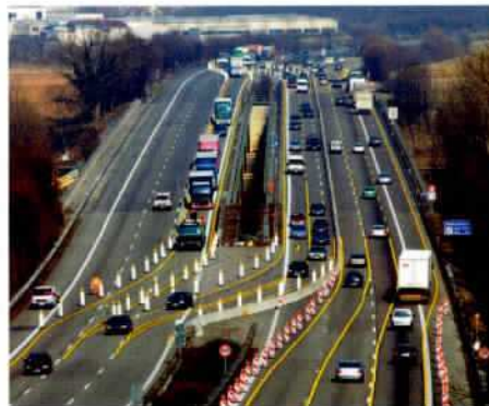
Arbeitsstelle: Die weißen Markierungen werden von den gelben Markierungen vorübergehend aufgehoben
