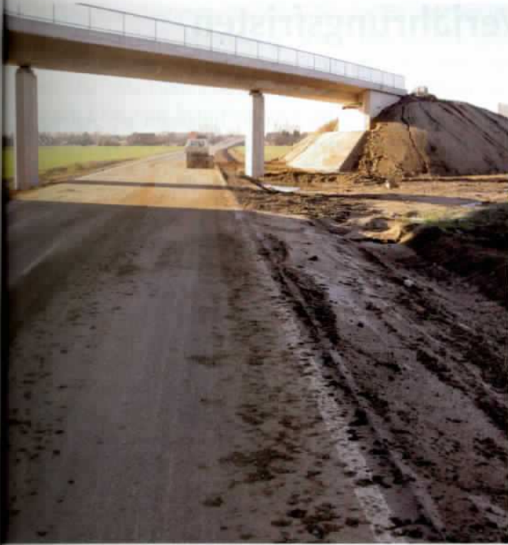
Die Fotos zeigen eine Neubaustrecke, auf die gerade eine neue Markierung aufgebracht wurde, die man wegen starker Verschmutzung kaum noch sehen kann. Sie dokumentieren, welchen Widrigkeiten neue Markierungen teilweise bereits vor der Abnahme ausgesetzt sind.
