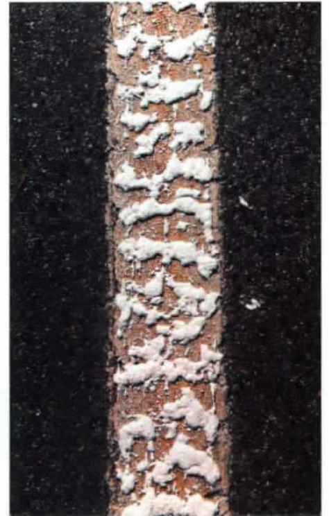
Das Foto zeigt eine qualitativ schlechte Agglomeratmarkierung, die auf eine vorhandene Altmarkierung appliziert wurde. Die Flächenbedeckung ist zu gering und zu ungleichmäßig.
