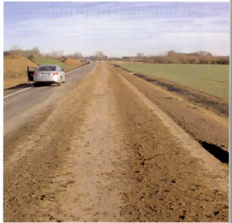
Die Fotos zeigen eine Neubaustrecke, auf die gerade eine neue Markierung aufgebracht wurde, die man wegen starker Verschmutzung kaum noch sehen kann. Sie dokumentieren, welchen Widrigkeiten neue Markierungen teilweise bereits vor der Abnahme ausgesetzt sind.
