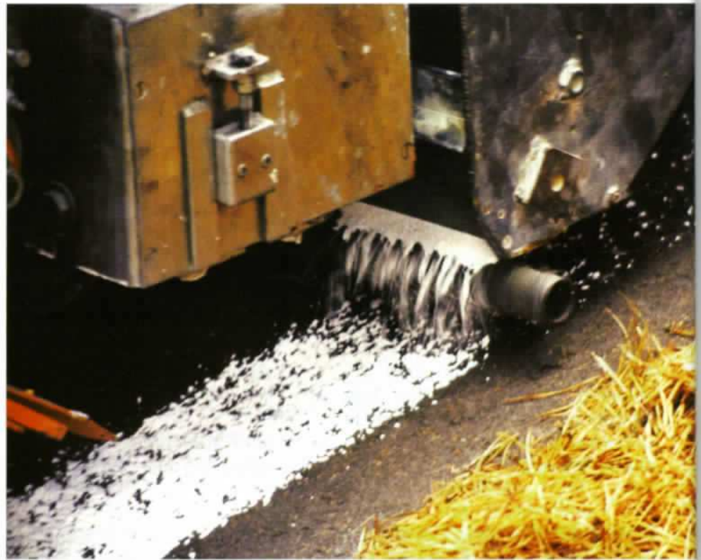
Das Foto zeigt die Applikation einer Agglomeratmarkierung mittels einer rotierenden Stachelwalze
